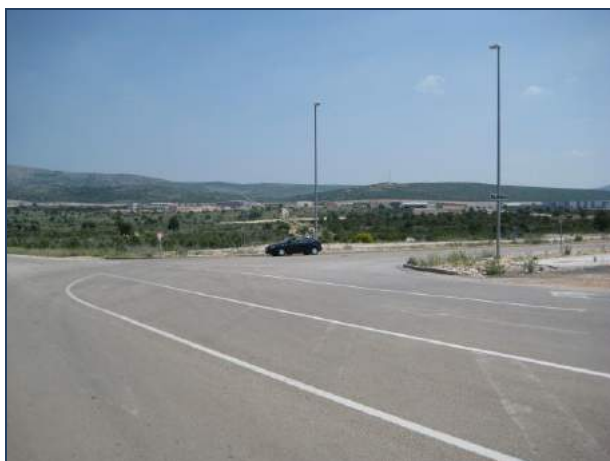
Postojeći objekt podvožnjaka koji se koristi
